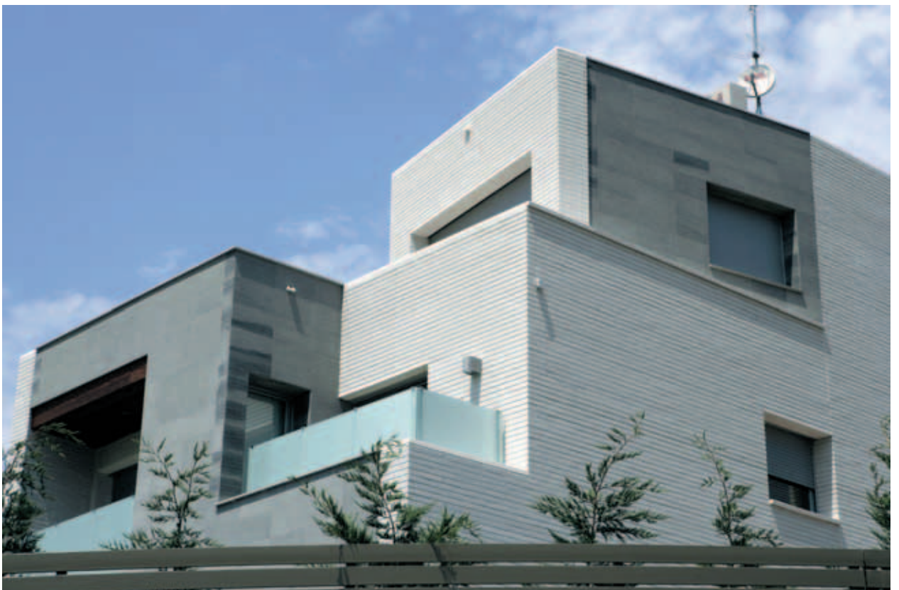
Casa unifamiliar (Castellar del Vallès)
