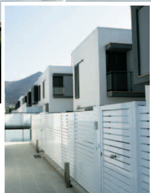
Conjunto casas unifamiliares (Roses)
